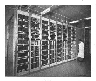
Fig. 9 Fertig installierte Telephonzentrale «Hasler System 52» Die Relais- und Suchereinheiten sind vorne mit Glasdeckeln und hinten (zweite Reihe) durch Metalldeckel vor Staub und Beschädigungen geschützt. Hinter den schmalen Metalldeckeln ganz oben und unten verlaufen die Kabel
