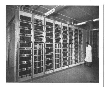
Fig. 9 Fertig installierte Telephonzentrale «Hasler System 52»
