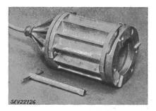
Ce luminaire est conforme au mode de protection pour sécurité accrue, au sens du projet de Prescriptions pour le matériel d'installation électrique antidéflagrant et l'appareillage de commande, élaboré par le CT 31 du CES. Utilisation: dans des locaux présentant des dangers d'explosion, avec gaz du groupe d'allumage B, resp. C.
