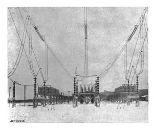
Fig. 8 380-kV-Seriekondensatorstation Im Betrieb seit Januar 1954
