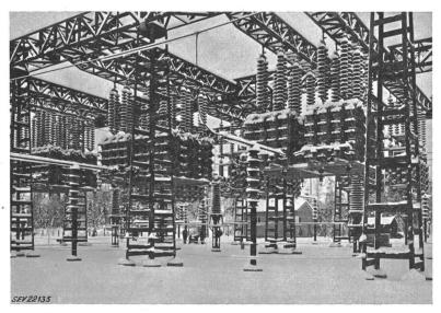
Fig. 7 **220-kV-Seriekondensators**tation Im Betrieb seit Januar 1950
