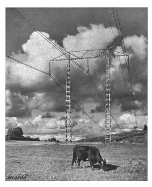
Fig. 5 380-kV-Leitung mit Bündelleitern
