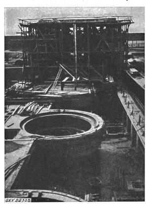
Die Fundamente für die Kaplanturbinen im Kraftwerk von Tiszalök
