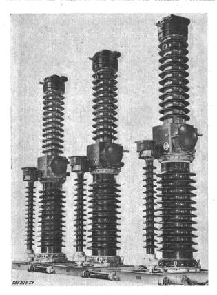
Fig. 1 Ölstrahlschalter Typ HPF 311 k, 110 kV, 1000 A, 2500 MVA
