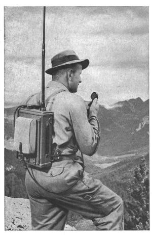
Fig. 1 Drahtloses Telephongerät SE 812
