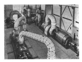
Fig. 3 Gasturbinenanlage für 20 000 kW Leistung in Weinfelden
