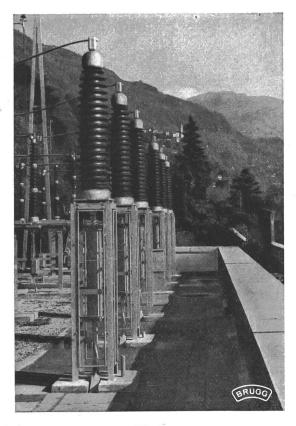
Fig. 1 225-kV-ölkabelanlage Verbano der Maggia Kraftwerke A.-G.
