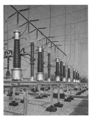
Fig. 1 Stromwandler für 220 kV
