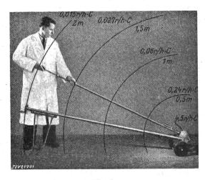
Fig. 1 Fahrbarer Transport- und Arbeitsbehälter für radioaktive Strahler Herausnehmen des Manipulators
