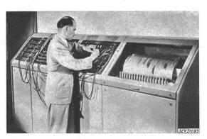
Fig. 2 Steuerwalze zur selbsttätigen Abwicklung eines Kurzschlussversuches
