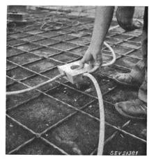
Fig. 2 Verwendung bei Lampendübeln
