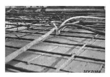
Fig. 1 Ductub-Schläuche vor dem Einbetonieren
