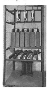
vanisch von der Hochspannungsseite und erlaubt eine gute Anpassung des Generators an die Netzimpedanz. Fig. 9 zeigt die Kopplungsglieder für das 3,5-kV-Netz des Elektrizitätswerkes der Stadt Solothurn.
