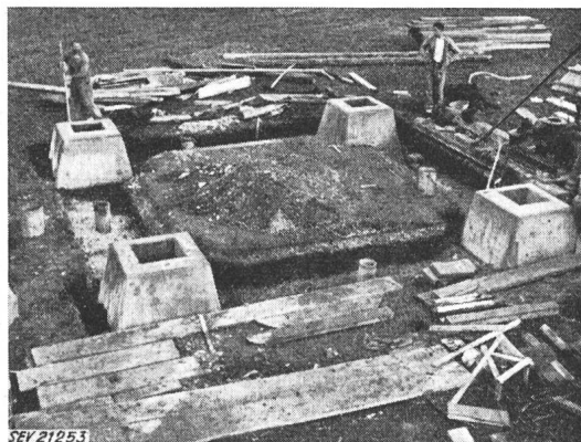
Fig. 12 Fundamentbau auf der 380-kV-Leitung Amsteg—Mettlen Rahmenfundament, Baujahr 1947
