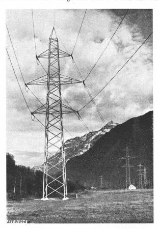
Fig. 5 Abspannmast mit ausbetonierten Stahlrohren der 380-kV-Leitung Amsteg—Mettlen Baujahr 1947
