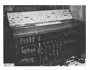
Fig. 3 Stellwerk Luzern für Fernsteuerung der Weichen und Signale in Sentimatt und Fluhmühle
