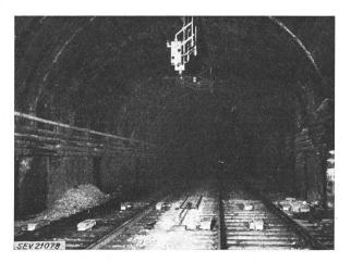
Fig. 8 Gleismagnete der Zugsicherung bei den Signalen der Blockstation Gotthardmitte
