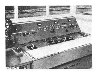
Fig. 2 Normalstellwerk für kleine und mittlere Stationen der SBB (Würenlos)
