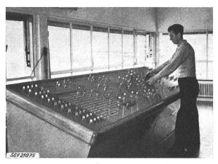
Fig. 5 Gleisbildstellwerk Genf, ohne Weichenschalter und ohne mechanische Verschlüsse der Fahrstrassensignalschalter
