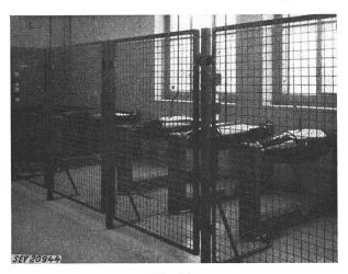
Fig. 14 Sechs Spannungswandler, Pol-Erde, 60 kV
