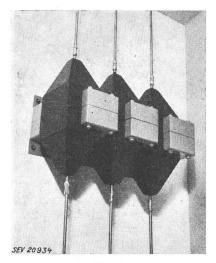
Fig. 4 Dreiphasen-Spannungswandlerbatterie, 20 kV
