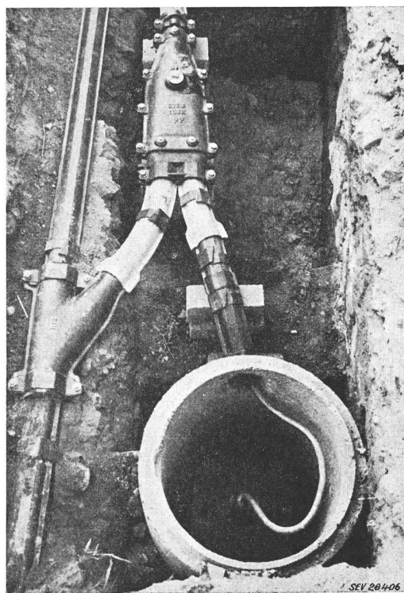
Fig. 1 Fernkabel mit Abzweigmuffe und Pupinschacht
