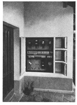
Fig. 2 Geöffneter Zählerkasten, Isolierplatten über Kabelendverschluss und Sicherungen entfernt, Milchkasten offen Cliché: Schweizerische Bauzeitung
