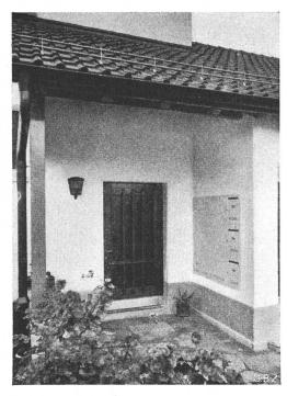
Fig. 1 Hauseingang. Rechts neben der Haustüre der Kasten für Zähler, Schaltuhren und daneben die Brief- und Milchkästen Cliché: Schweizerische Bauzeitung
