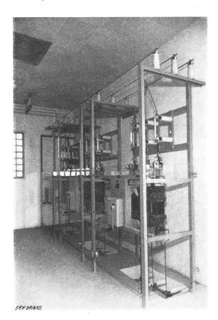
Fig. 6 16-kV-Anlage im 1. Stock, mit ölarmen Schaltern ausgerüstet
