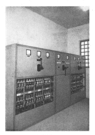
Fig. 7 380/220-V-Verteilschrank im 1. Stock
