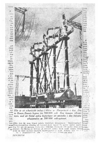
Fig. 9 Der 380-kV-Druckluftschalter Brown Boveri im Spiegel der schwedischen Presse
