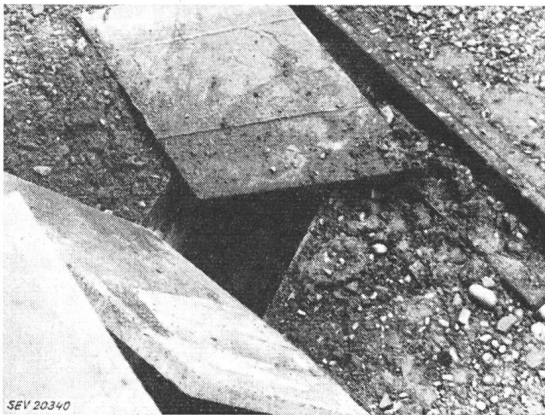
Fig. 10 Abgehobene Abdeckplatten des Kabelkanals Gewicht pro Stück ca. 25 kg
