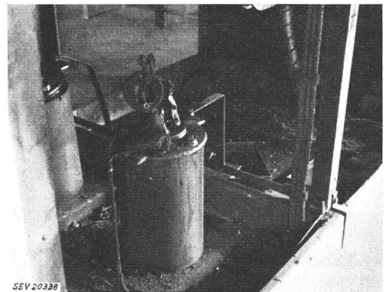
Fig. 8 Zerstörter 16-kV-Ölstromwandler im 1. Stock
