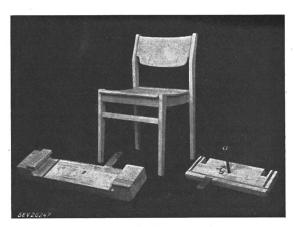
Fig. 17 Hochfrequenzverleimung von Stühlen in mehreren Arbeitsgängen
