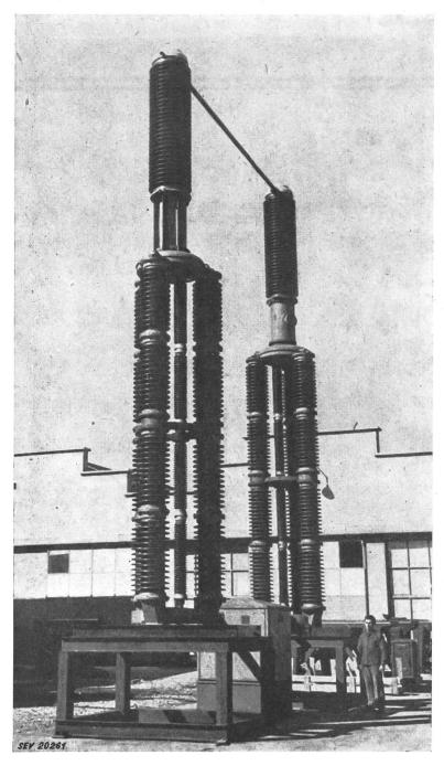
Fig. 1 Ein Pol eines 380-kV-ölstrahlschalters
