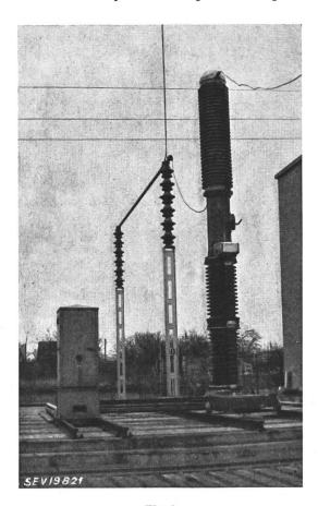
Fig. 1 Disjoncteur unipolaire pour 220 kV avec commande sur la plate-forme de Fontenay
