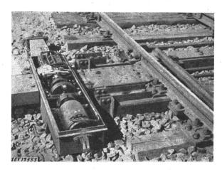
Fig. 1 Elektrischer Weichenantrieb
