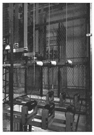
$Fig.~12\\ 2\times 3~transformateurs~de~tension~secs,~p\^ole—terre,~20~kV\\ dans~une~installation~bavaroise\\ (Bayerische~Landeselektrizit\"{atsversorgung})$
