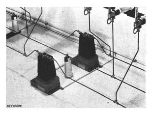
Fig. 10 2 transformateurs d'intensité secs, 20 kV commutables au primaire pour 2 domaines de mesure (Services industriels de la Ville d'Aarau)
