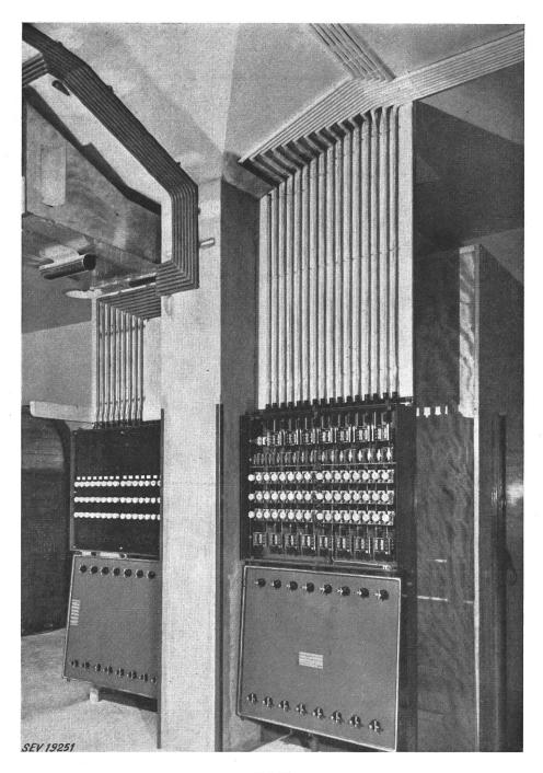
Fig. 40 Appareillage de distribution blindé Installé en 1951
