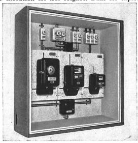
Fig. 29 Appareillage de distribution disposé de façon à ne pas pouvoir provoquer d'incendie Exécuté selon le schéma de la fig. 28 a
