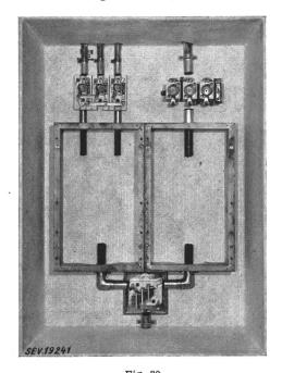
Fig. 30 Appareillage de distribution simple, avec dispositifs de mesure Echelon de montage intermédiaire, selon la nouvelle méthode
