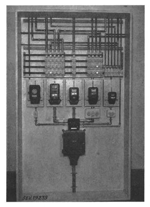
Modèle d'appareillage de distribution, de protection et de mesure pour l'éclairage, la force motrice, les applications thermique, un grand chauffe-eau à accumulation et un circuit à forfait, avec lignes disposées dans deux plans parallèles
