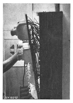
Fig. 2 Même tableau que celui représenté sur la fig. 1 L'arrière constitue un véritable fouillis
