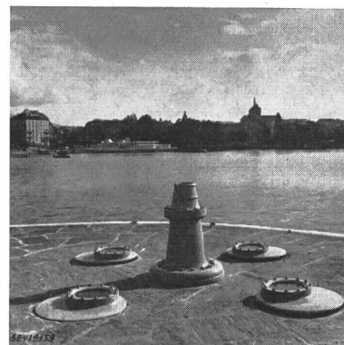
Fig. 7 Tuyère et projecteurs encastrés dans la dalle supérieure
