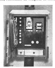
compteur d'éclairage, avec coupe-circuit principaux et de distribution (25, 20, 10 et 6 A, respectivement), deux prises de courant 2 P + T, 6 A, 250 V, et deux prises industrielles latérales 15 A, 3 P + T, pour changement du sens de rota-
