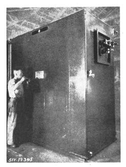
Fig. 3 Stickstoffgefüllter Trockentransformator 1250 kVA, 15 kV Oberspannung
