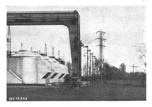
Fig. 1 Vertikalachsige Synchronkompensatoren
