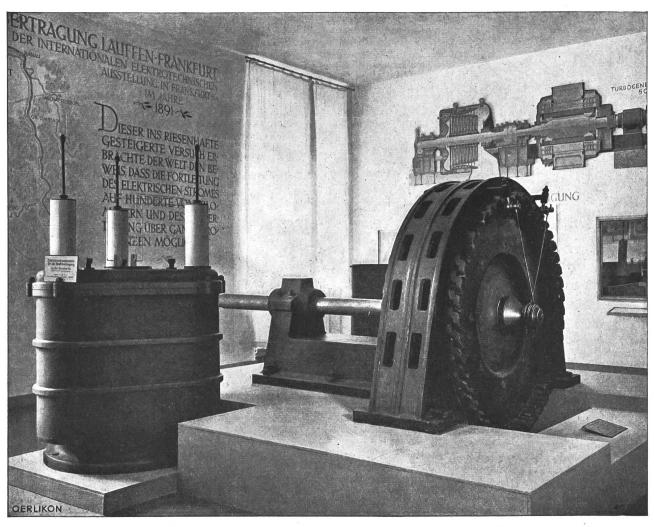
Fig. 2 Einer der beiden Drehstromgeneratoren, 210 kW, aus dem Kraftwerk Lauffen 1891
