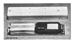
de chauffage. Condensateur de déparasitage de 0,04 µF en parallèle avec la lampe. Condensateur d'allumage de 0,0016 µF entre boîtier et réseau. Bornes sur socle en matière isolante moulée.
