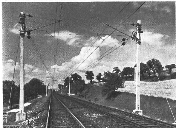
Fig. 3 Fahrleitung der Einheitsbauart der ÖBB Strecke Linz—Amstetten
