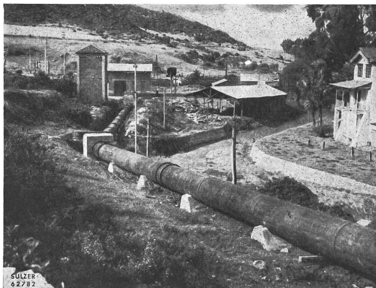
Fig. 4 Die Druckleitung Im Hintergrund das Pumpwerkgebäude
