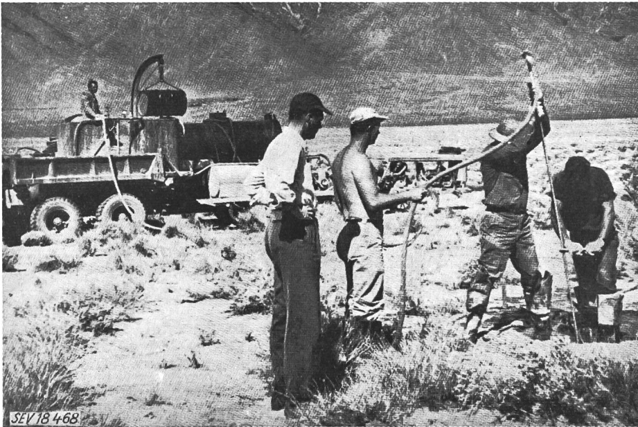
Fig. 1 Das Bodenverfestigungsaggregat während der Arbeit
