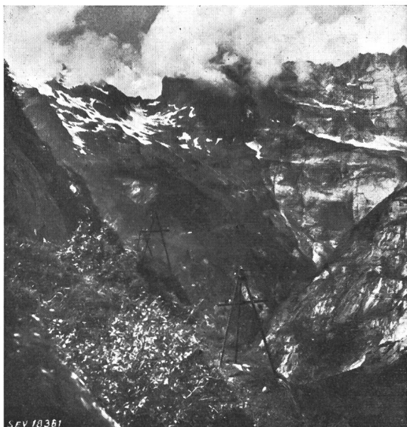
Fig. 1 Dreieck- und Pyramiden-Masten 16-kV-Leitung Innertkirchen-Gauli
