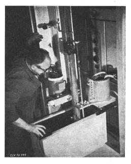
Fig. 6 Härteeinrichtung für automatischen vertikalen Vorschub mit Temperaturkontrolle
