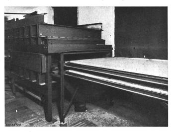
durch eine solche profilierte Türe. Eine Platte mit Abmessungen von  $180\times60\times2,5$  cm ist in 8...10 min verleimt und bereit, weiter bearbeitet zu werden (Schleifen, Beizen, Polieren). Die Elektrodenanordnung zeigt Fig. 10. Die Profile bedingen Einlagen aus Hartholz oder einem wärmebeständigen, nicht leitenden Material. Um das elektrische Feld und somit die Erwärmung homogen zu gestalten, darf die Elektrode nicht den Konturen der Platte folgen, sondern sie muss plan bleiben.
