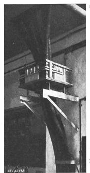
als vollkommen falschstromfrei erwiesen. Fig. 12 zeigt den Kabelringwandler mit den 5 Verbindungskabeln, welcher den Gehäuseschlußschutz eines Generators von 15 200 kVA besorgt, der bei 6 kV mit anderen gleichartig geschützten Generatoren auf ein kombiniertes Kabelund Freileitungsnetz arbeitet. Der kompensierte Erdschlussreststrom schwankt zwischen ca. 0,5 A (bei Gehäuseschlüssen am
