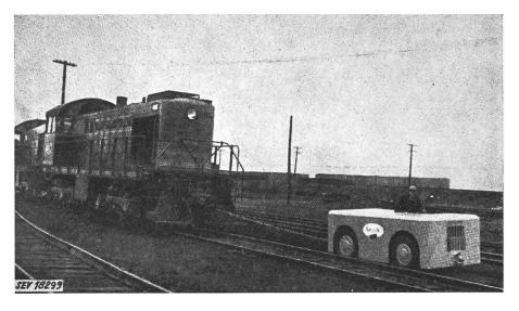
Fig. 1 Industrie-Traktor, einen Güterzug schleppend
