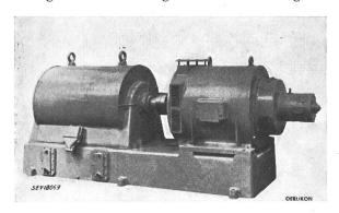
Fig. 9 Umformergruppe 300 kW, 487 Hz, 1470 U./min (System MFO)
