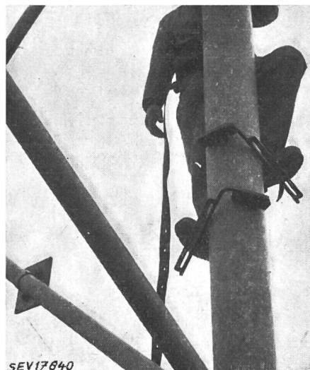
Fig. 6 Grimpettes pour pylônes en tubes d'acier Ces grimpettes peuvent être facilement adaptées aux différents diamètres de tubes
