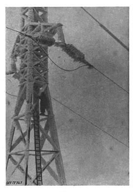
Fig. 3 Pylône 200 I. Légères brûlures de la boucle d'un conducteur
