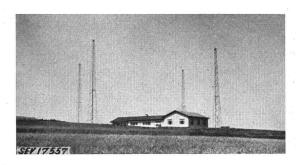
Fig. 7 Die Sendestation Waltikon mit den Masten für die Langwellenantennen
