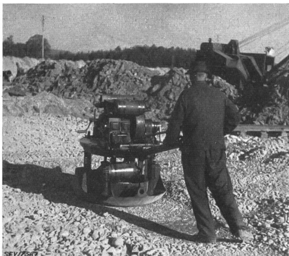
Fig. 7 Verdichten des Kieskoffers mit dem Vibrator
