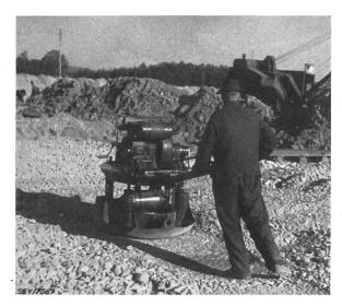
Fig. 7 Verdichten des Kieskoffers mit dem Vibrator
