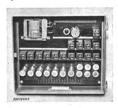
secs ou temporairement humides. Grâce au couplage spécial, aucune étincelle dangereuse ne peut se produire aux contacts à manipuler, de sorte que les boutons-poussoirs utilisés n'ont pas besoin d'être d'un modèle antidéflagrant.
