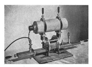
Fig. 5 Verstärker für Mikrowellen der International Telephone and Telegraph Corp.
