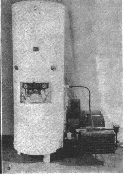
Die American Gas & Electric Service Corp. in New York hat sich daher entschlossen, diese Frage an Hand einer Reihe systematischer Versuche abklären zu lassen. Die Kühlwirkung des Verdampfers kann gleichzeitig zur Raumkühlung herangezogen werden. Vielerorts dürfte sich ein Warmwasser-
