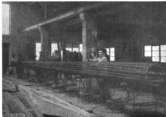
Fig. 3 Flecht-Tisch Armierung eines Mastes kurz vor der Vollendung
