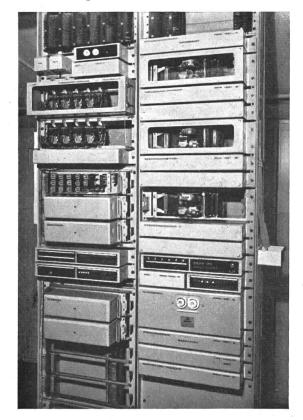
Fig. 1 Steuereinrichtung der zentralgesteuerten Verkehrssignal-Anlage
