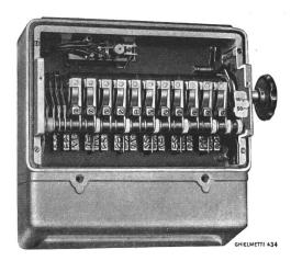
Fig. 2 Automatischer Netzumschalter mit Motorantrieb und regulierbarem Spannungsrelais
