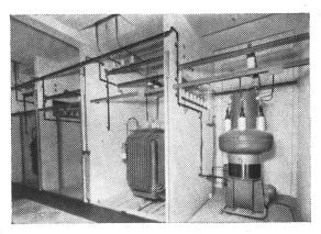
Fig. 1 Innenansicht der Gleichrichteranlage du Sahel in Algier Betriebsspannung 625 V, Nennstrom  $3 \times 400$  A
