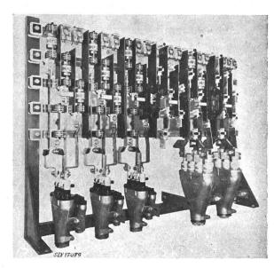
Fig. 1 Kombination von Sicherungen und Sammelschienen in Betonkabinen für Verteilpunkte in Orts- und Stadtnetzen
