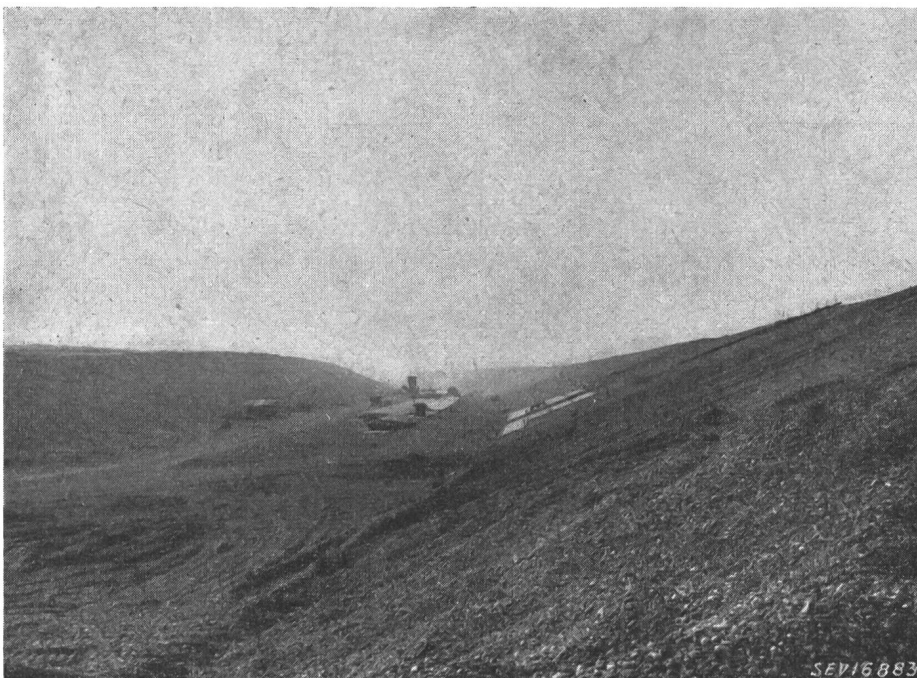
Fig. 10 Der fertig ausgehobene Kanal mit den fertig angeschütteten Uferdämmen. In Bildmitte sieht man das Einbringen der Sohlen- und Böschungs- Betonplatten (vorfabrizierte Platten)
