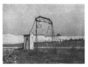
Fig. 9 Die «Kabelbrücke» über eine Strasse Das mehrere 100 m lange Hochspannungskabel von der Jahrbaren Transformatorenstation zum Bagger kreuzt auch Wege und Strassen. Dort sind die auf dem Bild sichtbaren «Kabelbrücken» aufgestellt fahrbaren
