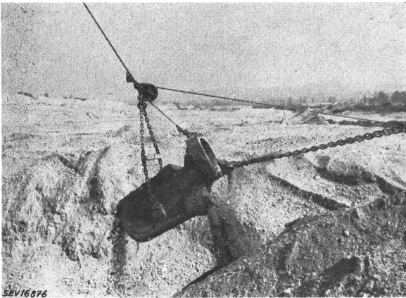
Fig. 3 Die Schaufel des amerikanischen Riesebaggers fasst 7 m³ Material. Die Schaufel ist so gross, dass ein Jeep bequem darin Platz findet
