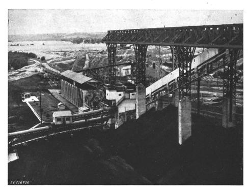
den Kohle von 65 % auf etwa 15...18 % herabgesetzt. Nachher leiten automatische Förderbände die Kohle weiter auf die Heizroste der Dampfkessel, wo mit 30 t/h Braunkohle etwa 35 000...45 000 kg/h Dampf erzeugt wird.
