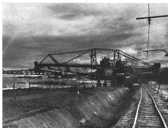
Fig. 2 Abbau-Bagger, der gleichzeitig die zum Transport benötigte Fahrbahn herstellt
