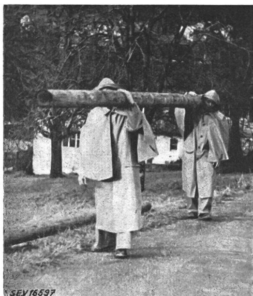
Fig. 5 Monteure beim Stangentragen
