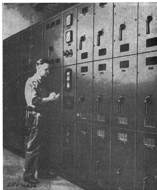
Fig. 10 Verteilanlage für Innenraum, aus vorgefertigten Schalteinheiten zusammengesetzt
