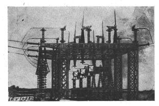
Fig. 1 500-kV-Schaltanlage mit General-Electric-Schaltern
